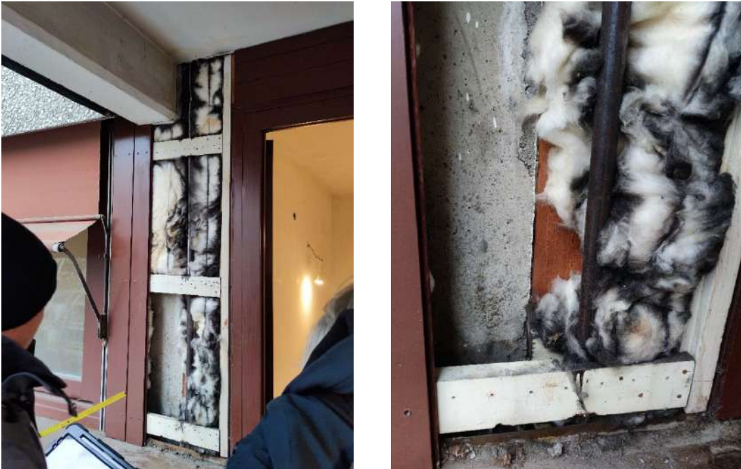
Abbildung 11: Anschluss Brüstung zur Innenwand, RfM Architektur
