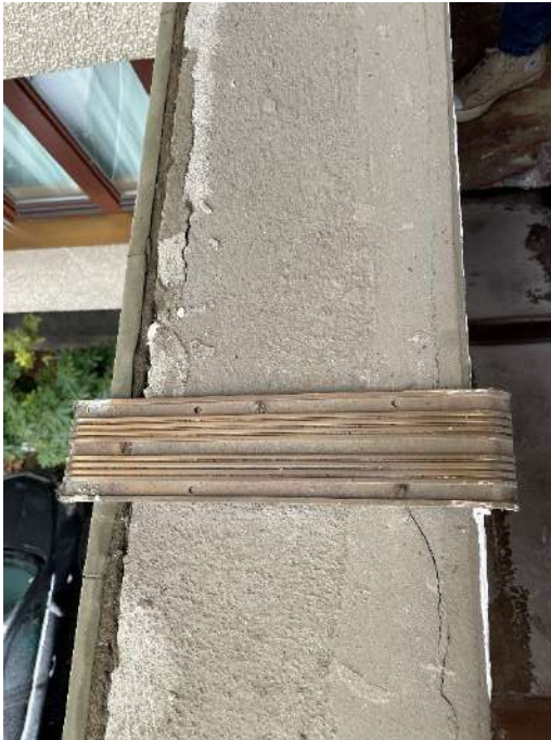
Abbildung 12: Brüstung Loggia, RfM Architektur
