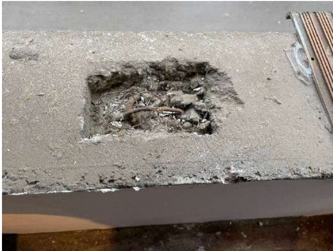
Abbildung 13: Brüstung Loggia, RfM Architektur
