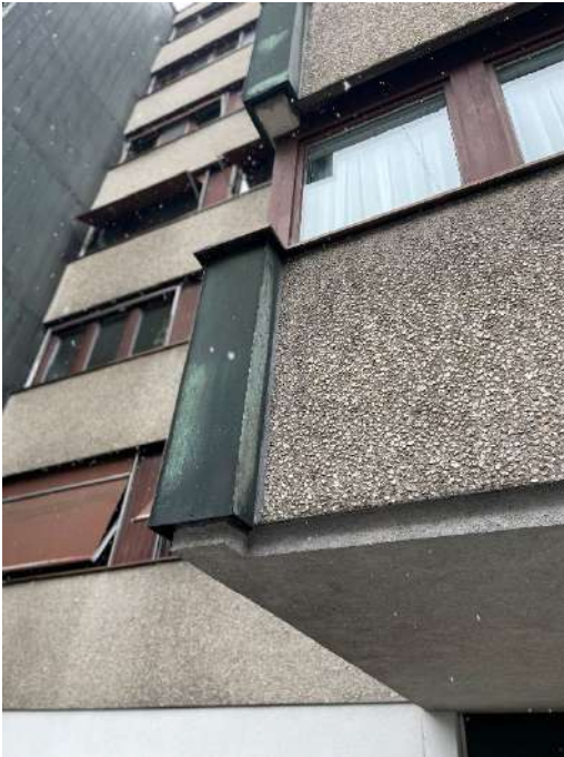
Abbildung 16: Eckverbindung Außenwand Wohnzimmer, RfM Architektur
