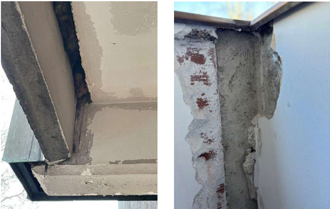
Abbildung 18: Brüstungsecke Loggia, RfM Architektur
