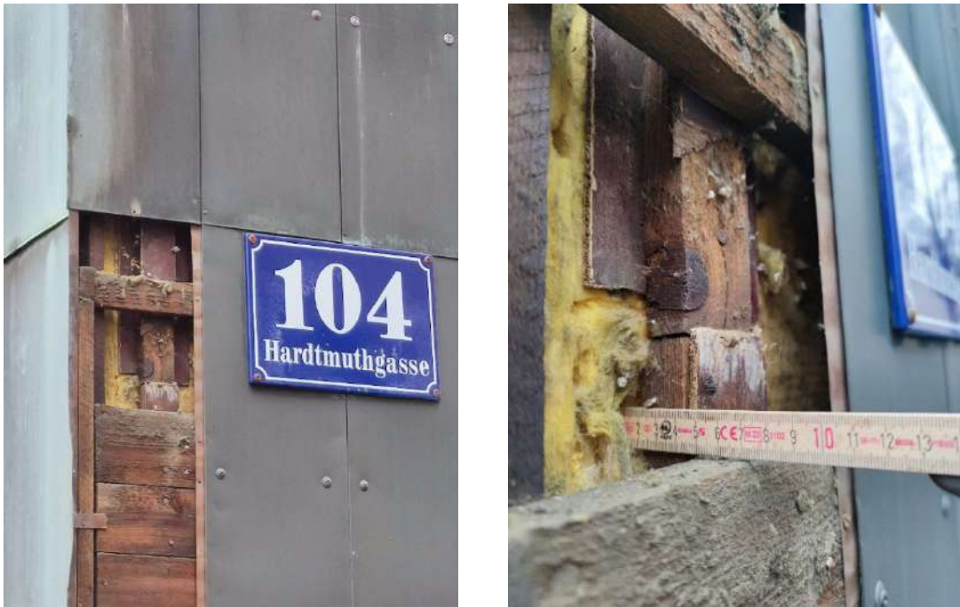
Abbildung 10: Fassadenaufbau, RfM Architektur
