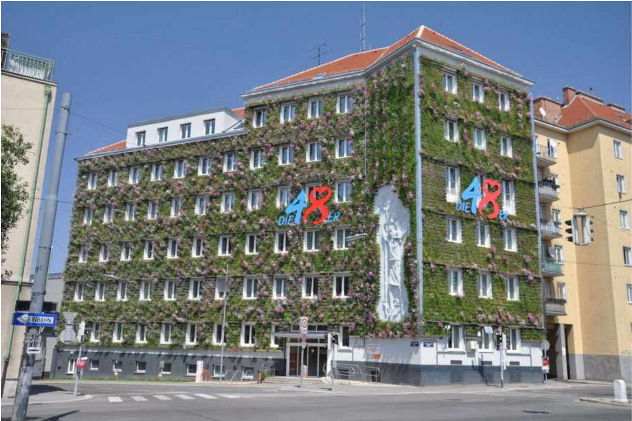
Abbildung 50: Begrünte Fassade Einsiedlergasse 2, 1050 Wien, (GrünstattGrau, kein Datum)
