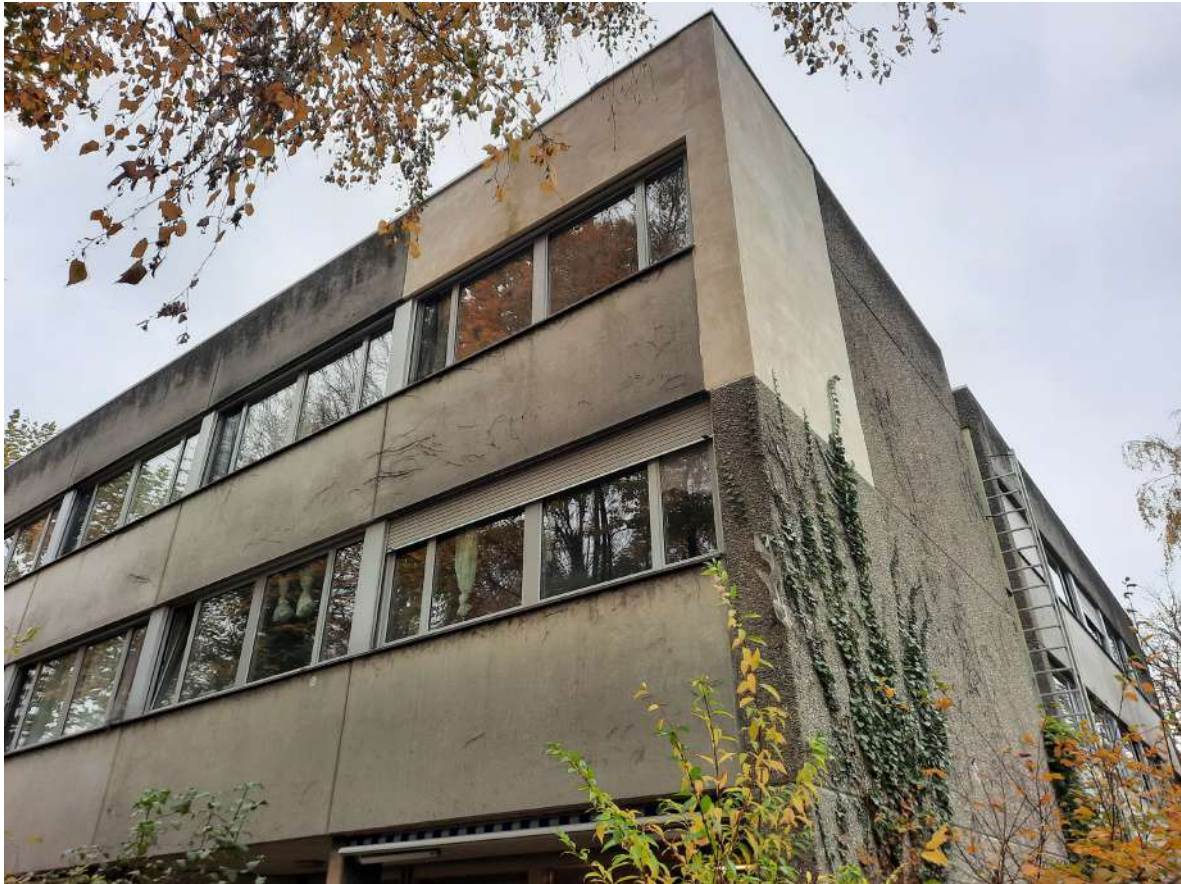
Abbildung 3: Foto des Wohnhauses Egilseestraße in Basel, TU Wien
