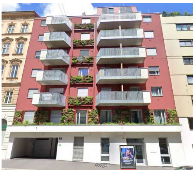
Abbildung 52: Begrünte Fassade Wiedner Hauptstrasse 150, 1040 Wien, (View, kein Datum)
